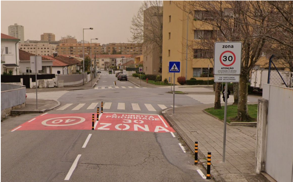
Fig. 62 Sinalização de entrada em zona 30 em Matosinhos
