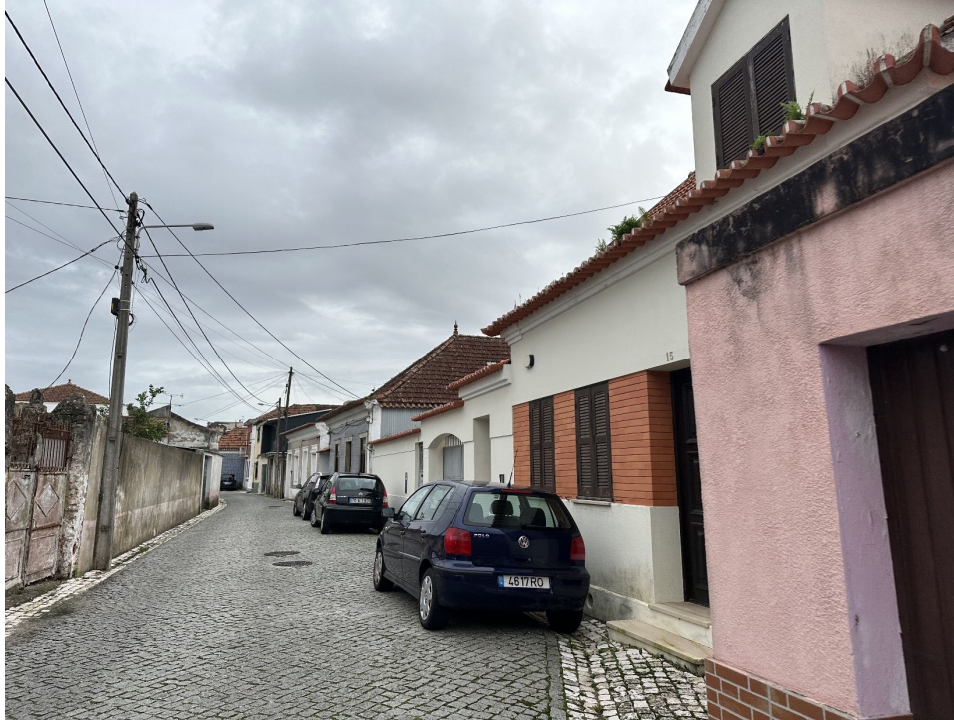
Fig. 61 Arruamento sem passeios no centro de São Salvador
