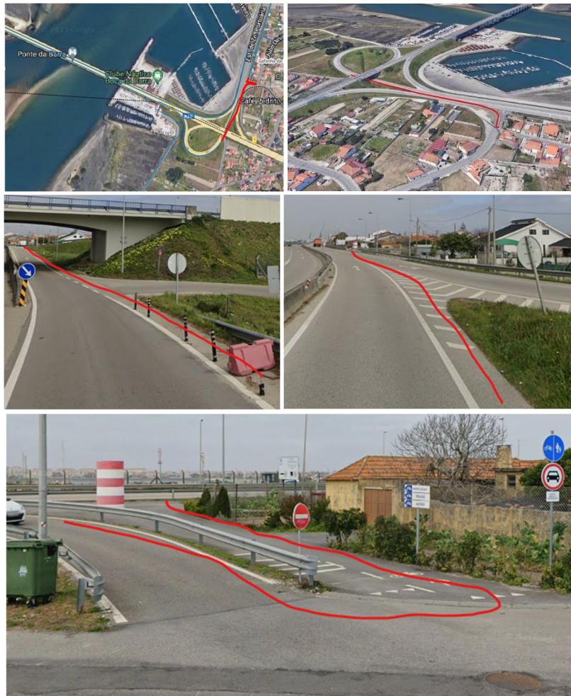
Fig. 75 Conflito automóvel – bicicleta no nó da A25 que dá acesso à Estrada da Zona Portuária Fonte das imagens: Google, 2023
