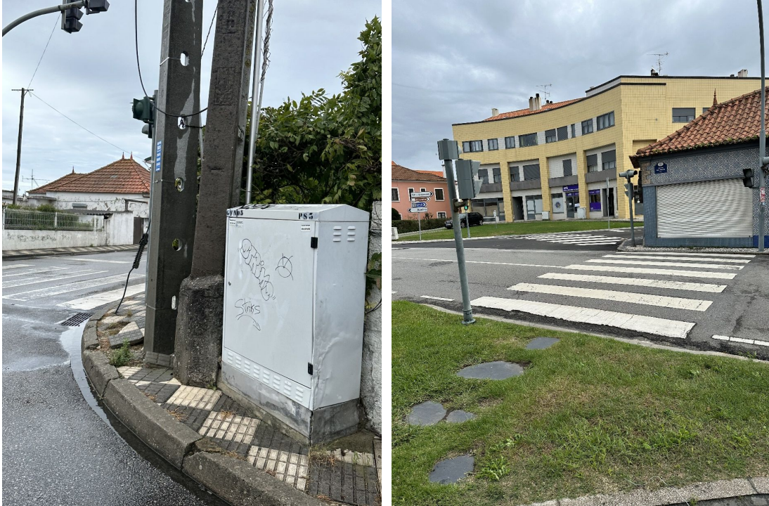
Fig. 64 Barreiras à circulação no passeio na Gafanha da Nazaré
