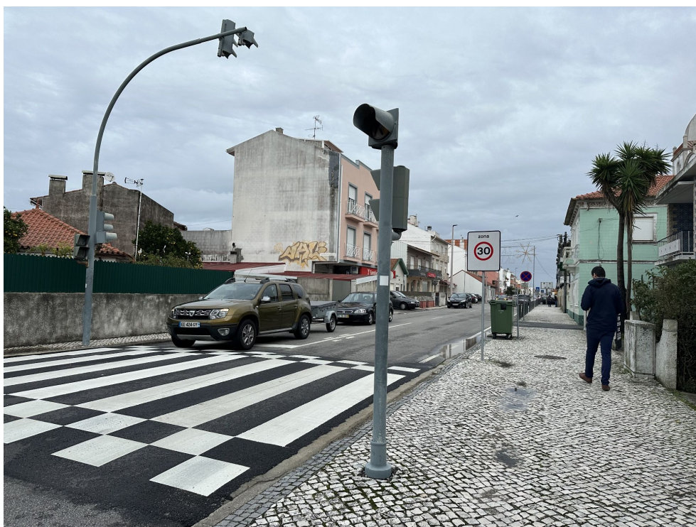
Fig. 50 Passadeira sobrelevada na Av. José Estevão na Gafanha da Nazaré
