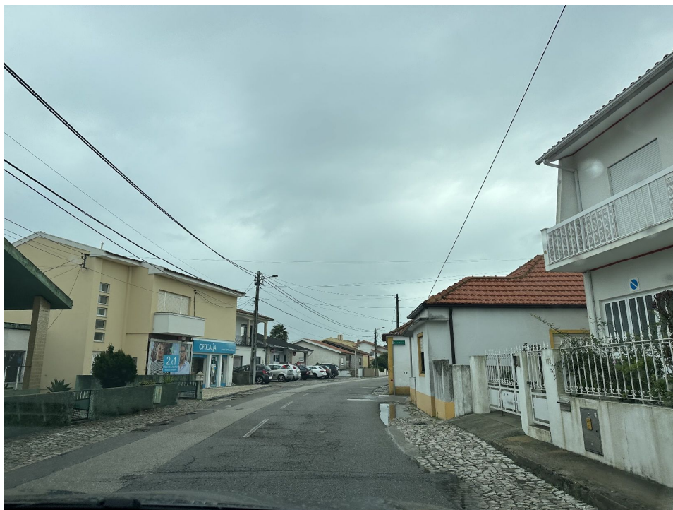
Fig. 66 Inconsistência da infraestrutura de circulação pedonal na Rua Prof. Francisco Corujo, na Gafanha da Encarnação
