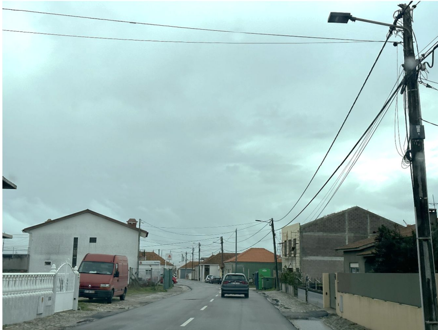
Fig. 25 Arruamento tipo na Gafanha da Encarnação
