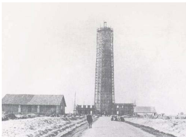
Farol da Barra em construção (inaugurado em agosto 1893)
