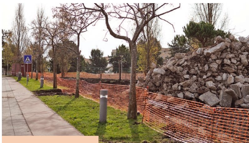
Requalificação do Parque da Malhada (PEDU/PARU Ílhavo) » 630.629,30 euros
