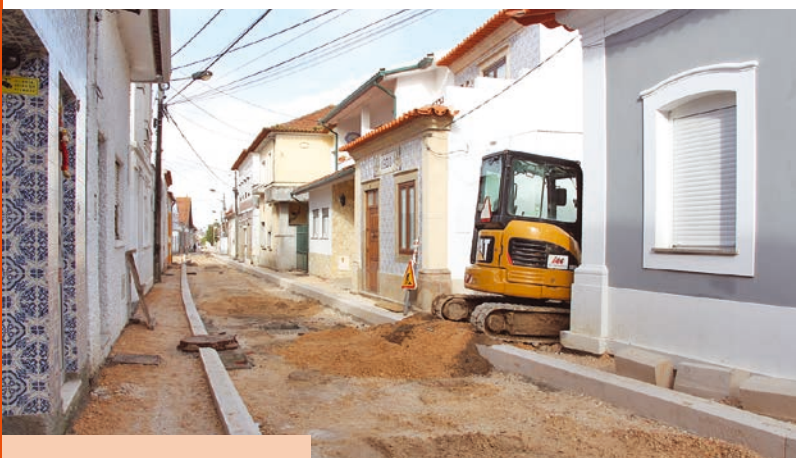
Requalificação Rua João Carlos Gomes, Ílhavo (PEDU/PARU Ílhavo) » 260.025,00 euros
