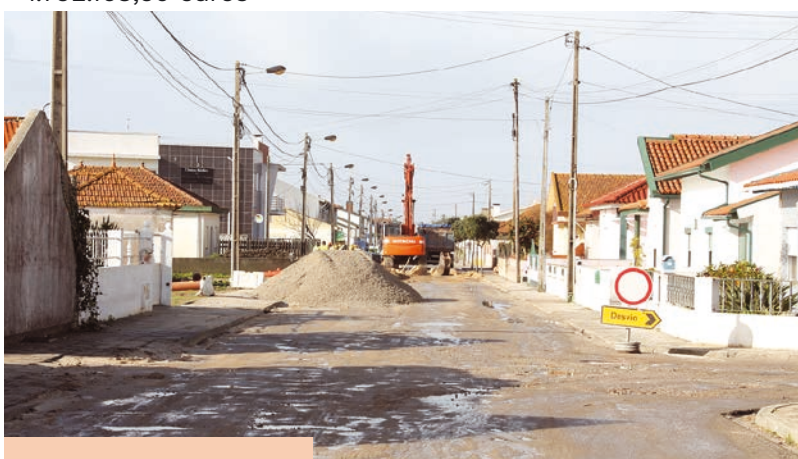
Rede de Drenagem de Águas Residuais e Pluviais da Gafanha da Encarnação » 1.526.481,79 euros
