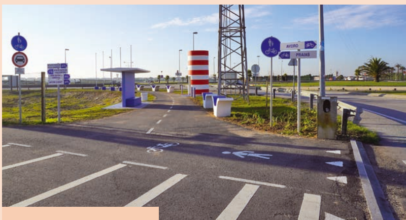
Pista de cintura externa na Gafanha da Nazaré (Bresfor – Ponte da Barra) » 351.869,00 euros
