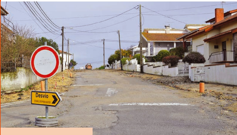
Requalificação do Bairro dos Pescadores (PEDU/PARU Ílhavo) » 623.459,40 euros
