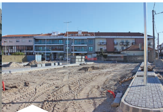
Construção de Parque de Estacionamento na Travessa de São Pedro, na Cale da Vila, Gafanha da Nazaré
