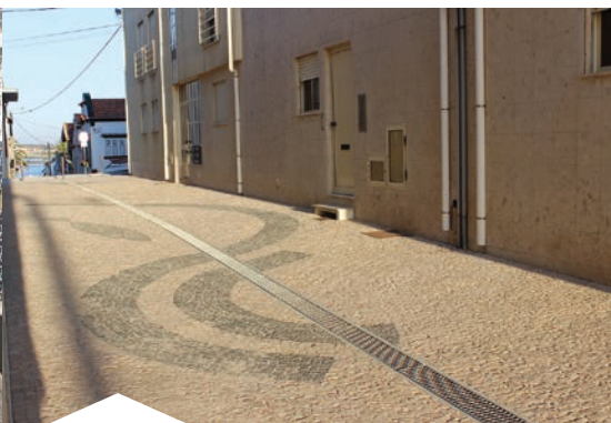
Pavimentação em diversos arruamentos do município
