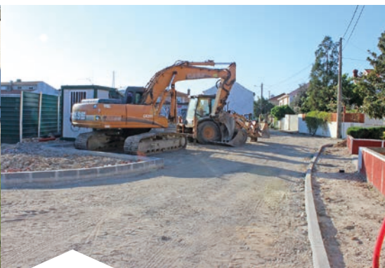
Construção das Redes de Águas Residuais (PAR201) – última fase
