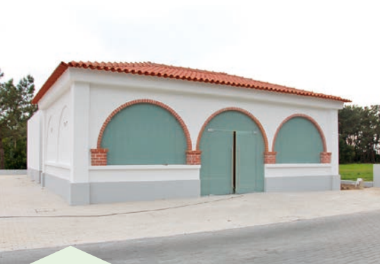
Capela/Casa Mortuária da Gafanha do Carmo
