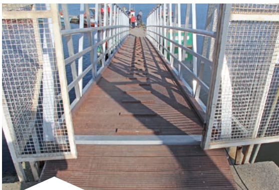
Montagem do novo passadiço no Ancoradouro da Costa Nova
