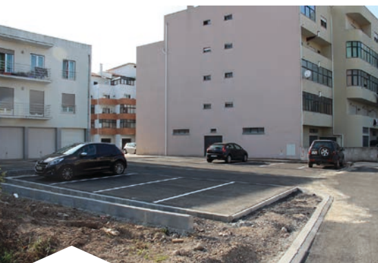
Construção de Parque de Estacionamento, Ílhavo
