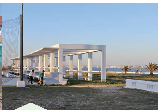
Requalificação da Av. Bela Vista, Costa Nova
