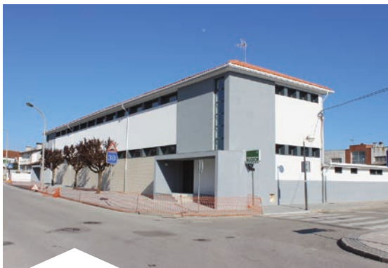
Novo Quartel da GNR de Ílhavo
