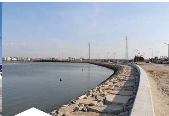
Marginal da Gafanha de Aquém – Execução de Enrocamento
