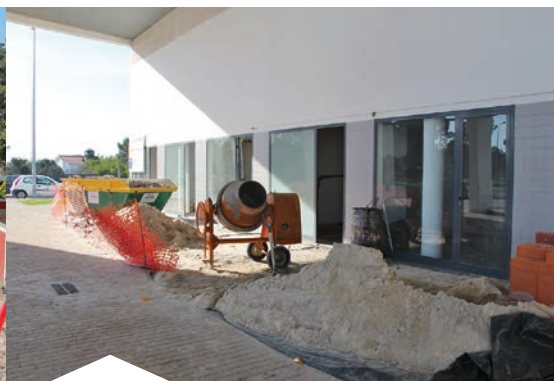
Construção dos Talhos (piso térreo) no Mercado da Gafanha da Nazaré
