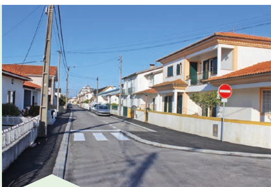
Construção de passeios na Rua D. Fernando, Gafanha da Nazaré
