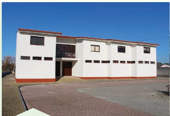
Conservação/Beneficiação do Centro Senhora da Paz - Vale de Ílhavo
