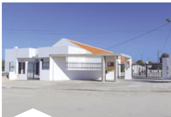
Requalificação da Escola da Chousa Velha
