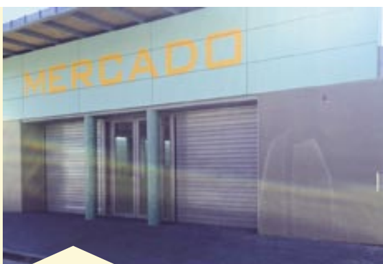
Requalificação e Ampliação do Mercado da Barra
