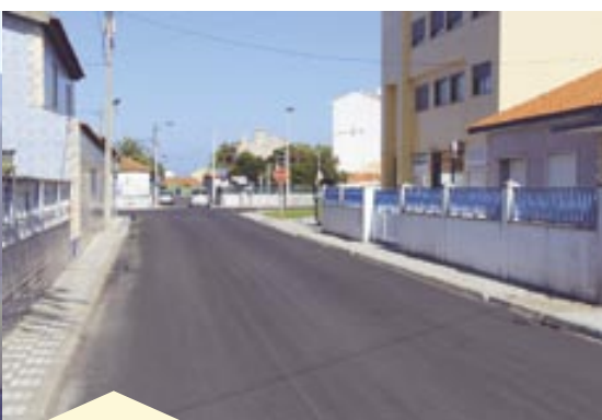
Revestimentos em Tapete Betuminoso no Município
