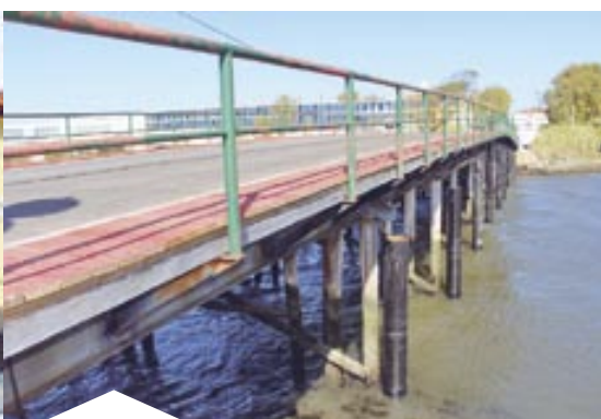
Remodelação da Ponte da Vista Alegre
