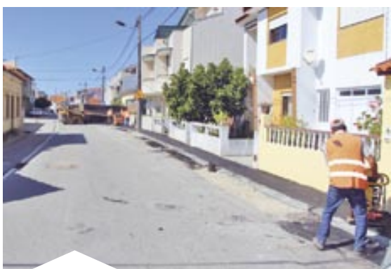
Requalificação da Rua D. Manuel Trindade Salgueiro, Gafanha da Nazaré
