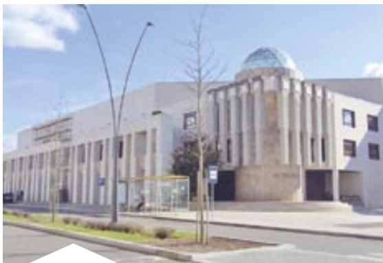
Adaptação e Conservação do Edifício Municipal - Coberturas e fachadas
