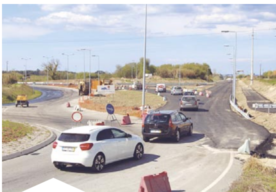
Via de Acesso ao PCI - Parque de Ciência e Inovação
