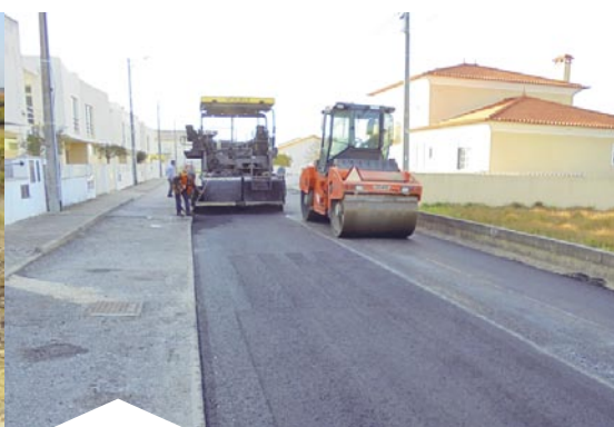
Revestimentos em Tapete Betuminoso no Município
