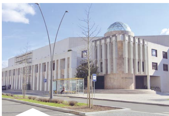
Adaptação e Conservação do Edifício Municipal - Coberturas e fachadas
