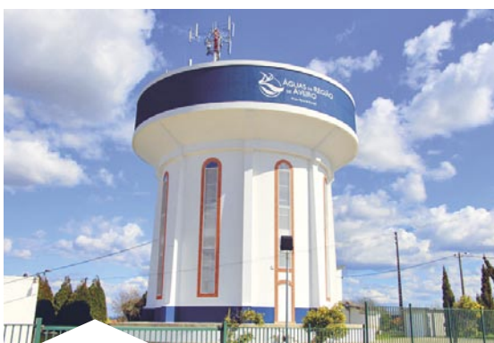
Beneficiação do Reservatório de Água na Lagoa (AdRA/CMI)
