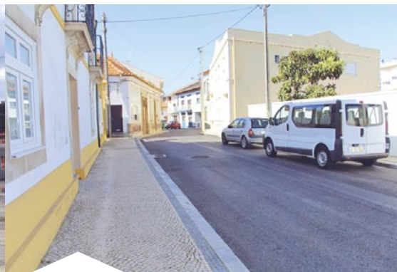
Requalificação da Rua de Alqueidão
