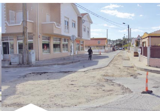
Rede de Saneamento e Águas Pluviais da Gafanha da Nazaré (AdRA/CMI)
