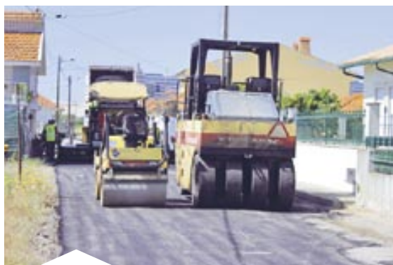
Saneamento da Gafanha da Nazaré (AdRA/CMI)
