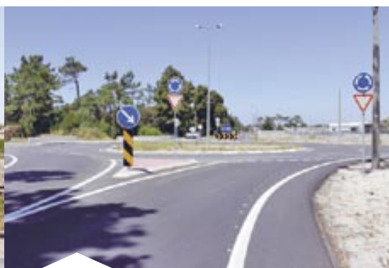
Requalificação da Estrada Florestal n.º 1 (1.ª Fase)
