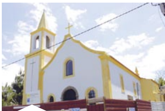
Conservação da Capela da Ermida
