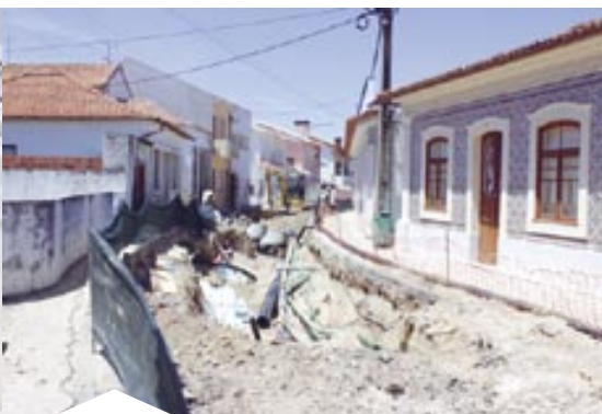
Redes de Drenagem de Águas Pluviais da Rua de Alqueidão, Rua Frederico Cerveira e Av. Manuel da Maia
