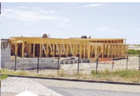
Edifício Sócio-Cultural e Extensão de Saúde da Costa Nova
