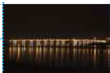
Ponte da Barra
