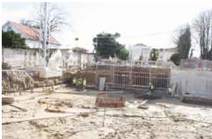
Hospital de Cuidados Continuados da Santa Casa da Misericórdia de Ílhavo
