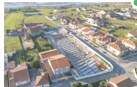
Construção de edifício com 32 fogos, Gaveto da Rua do Carmo, Gafanha da Encarnação
