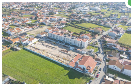
Construção de edifício com 32 fogos, Lugar do Bebedouro, Gafanha da Nazaré
