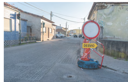
Ampliação das redes de águas residuais e pluviais na Gafanha da Encarnação e Gafanha do Carmo (PAR 012) - CMI/AdRA
