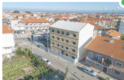
Reabilitação de edifício multifamiliar de 8 fogos, Rua Padre Manuel Bernardes, Gafanha da Nazaré
