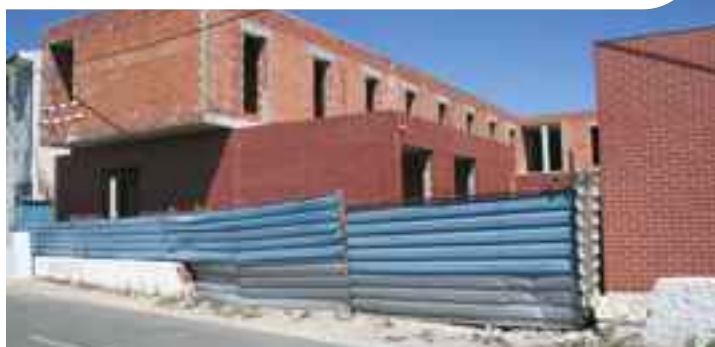
Centro Comunitário da Gafanha do Carmo
