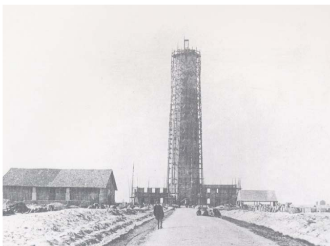
FIG. 25 - Farol da Barra em construção (inaugurado em agosto 1893)
