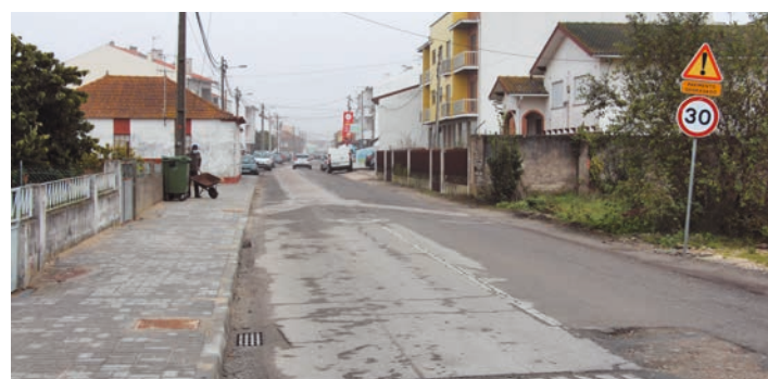
Requalificação da Rua S. Francisco Xavier, Gafanha da Nazaré » 506.393,80 euros
