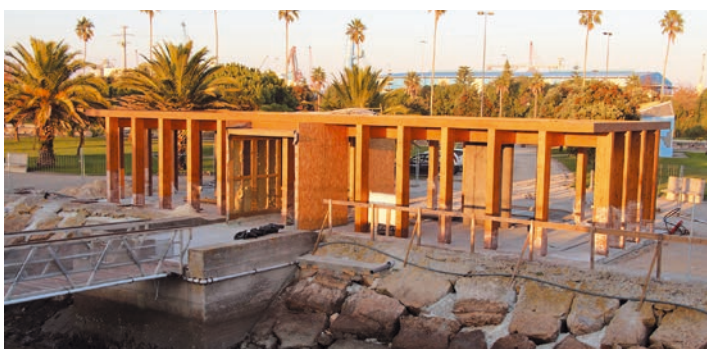
Projeto e construção da receção do Navio-Museu Santo André » 275.123,48 euros
