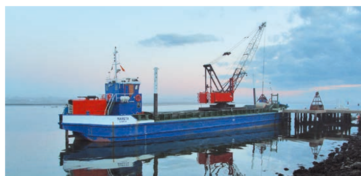
Dragagem de Manutenção Cais dos Pescadores na Costa Nova » 213.362,74 euros
