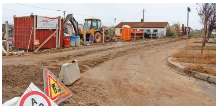
Requalificação da Rua das Cancelas, Ílhavo (1.ª fase) » 220.195,80 euros
