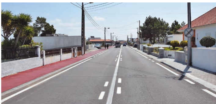
Construção do Corredor Ciclável no âmbito do PAMUS (Percurso 2) Gafanha de Aquém/Gafanha da Nazaré » 262.880,00 euros
