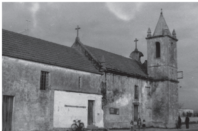
Lateral sul da capela antiga da Gafanha do Carmo [1965-71] Coleção João Gonçalves (Pe.). PT/CDILH/IMG/JG/CM1-005-004
