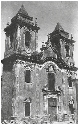
Igreja Matriz em obras [s/d]. Imagem cedida pelo Museu Marítimo de Ílhavo. Coleção Rocha Madahil. PT/CDILH/IMG/RM/2275
